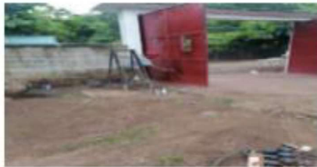
Foto 9: Se observa el trabajo de pintura y arreglo al portón de la entrada al escuela.
