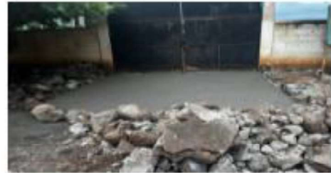
Foto 10: Se observa la colocación de la torta de cemento en la entrada a la escuela.
