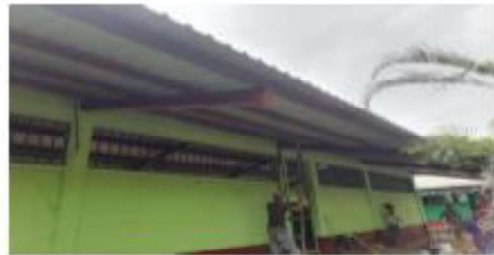
Foto 8: Se observa que se produce a la colocación de las costaneras nuevas.
