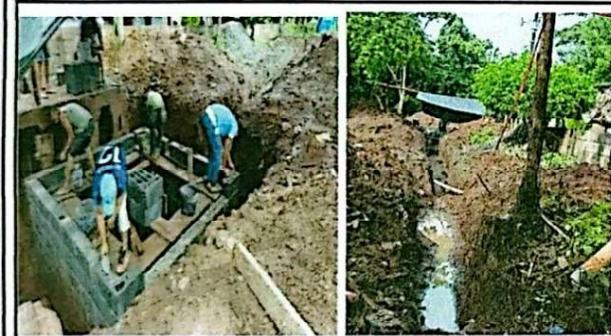
Foto 3: Se observa que hacen levantado de pared de la fosa y el zanjeo para la tubería principal de aguas negras.
