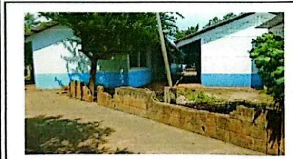
Foto 5: Se observa el muro perimetral deteriorado.
