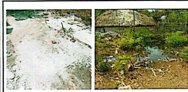
Foto 3: Se observa la fosa séptica disfuncional y no apta para los sanitarios.
