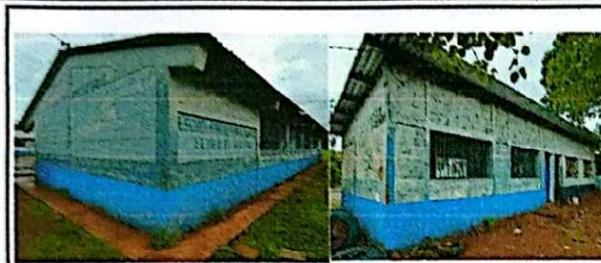
Foto 1: Se observa deteriorada la pintura del módulo 1 y 2
