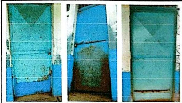
Foto 4: Se observan las puertas deterioradas en su totalidad del módulo No. 1
