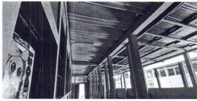
Foto 1: Se observa la necesidad de realizar la sustitución de lámina de cemento por lámina troquelada calibre 26.
