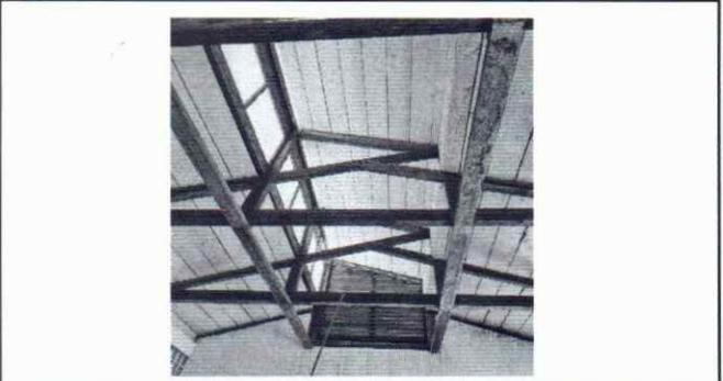
Foto 2 : Es necesario realizar la sustitución de la estructura de soporte de madera por madera.
