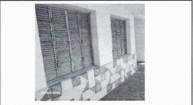
Foto 4 : Se observa el mal estado en que se encuentran las ventanas de madera, por tal razón deben sustituirse por ventanas de PVC.
