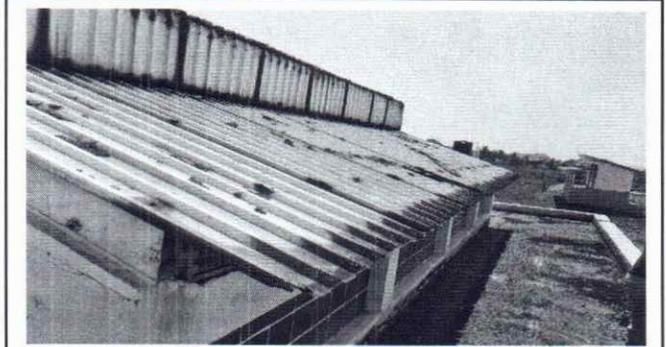
Foto 1: Se evidencia la necesidad de sustitución de la lámina existente por lámina troquelada calibre 26.
