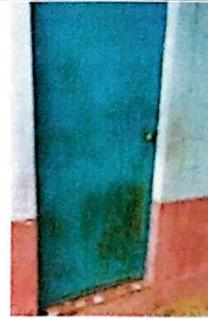
Foto 2: Se observa que las puertas necesitan mantenimiento.
