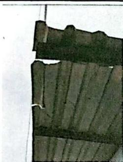
Foto 3: Se observa que las láminas se encuentran en mal estado.
