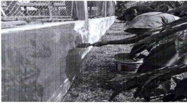
Foto 1: ejecución del raspado de la pintura existente y de la nueva pintura que se le esta colocando, en los muros interior y exterior del perímetro del centro educativo,
