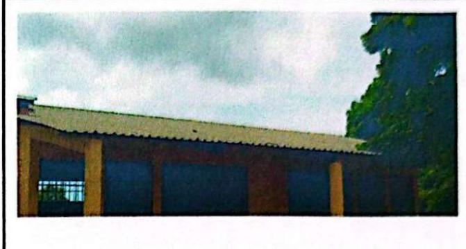
Foto 8: Se observa la necesidad de colocación de canales para agua
