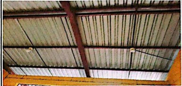
Foto 2: Se observa el mal estado de la estructura de metal debido al mal estado
