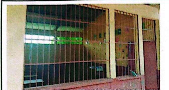
Foto 7: Se observa la necesidad de mantenimiento de balcon de metal y colocacion de ventanas mas vidrio
