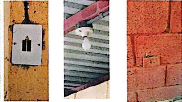
Foto 4: Se observa el mal estado del sistema electrico
