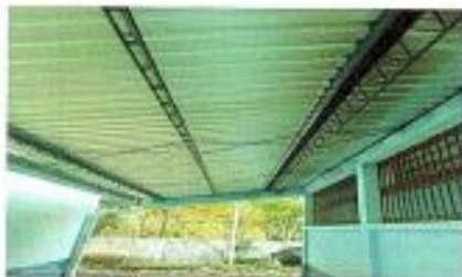
Foto 1: Colocación de teatro
