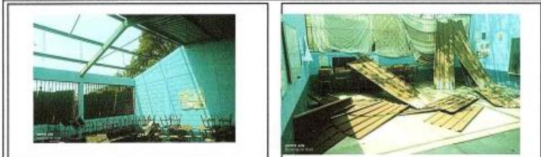
Foto 1: Se desmontó el techo Foto 2: Desmontaje de techos
