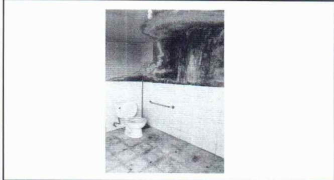
Foto 1: Se observa el sanitario en malas condiciones, es necesario sustituirlo.
