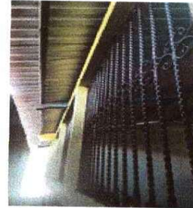
Foto 2: Se Observa los balcones con su mantenimiento y pintura debidamente terminados.
