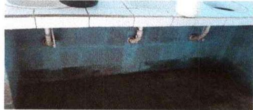
Foto 2: Se Observa: El Proceso de cambio de mangueras a los lavamanos
