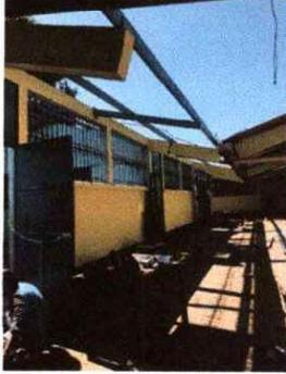
Foto 1: Se observa el desmontaje y proceso de pintura y montaje de la lamina que estaba en mal estado
