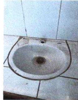
Foto 4: Se Observa: el desmontaje de de las llaves de los lavamanos
