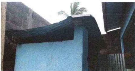
Foto 5: Se observa que la lámina existente y estructura de madera están en mal estado.
