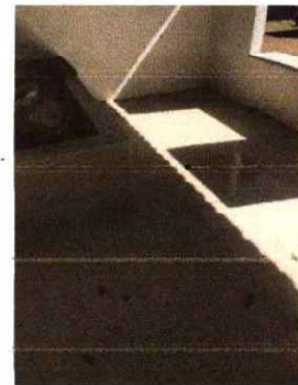
Foto 4: Se Observa el piso de la cocina terminando.
