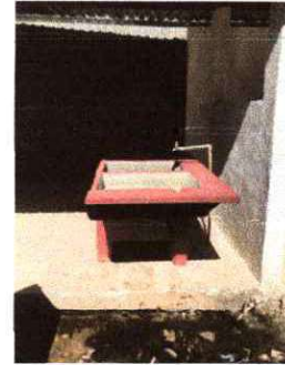
Foto 2: Se Observa la pila nueva instalada.
