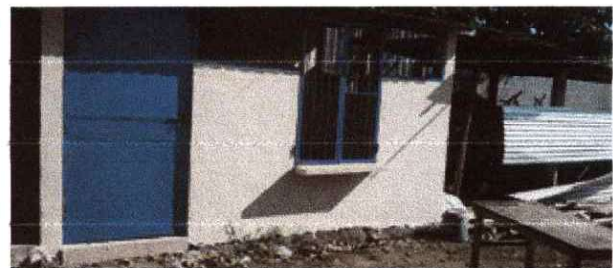
Foto 6: Se Observan los balcones y puerta terminadas.
