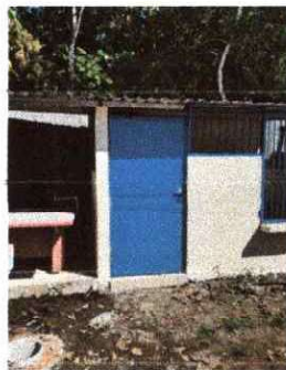
Foto 5: Se Observa las paredes repelladas y pintadas.
