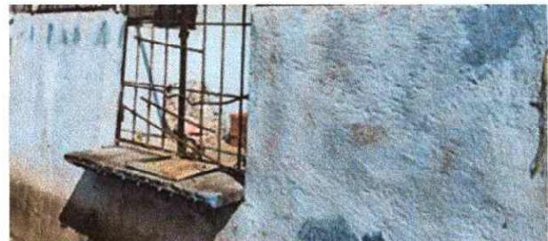
Foto 6: Se Observa la preparación de las paredes para la aplicación del repello.
