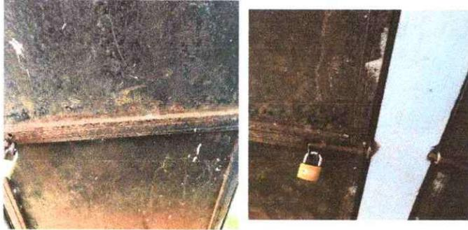
Foto 7: Se Observan las puertas a las que se sustituirán por estar en mal estado
