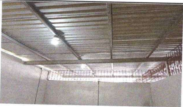
Foto 5: Se observa la finalización de instalación de energía eléctrica en aulas puras.
