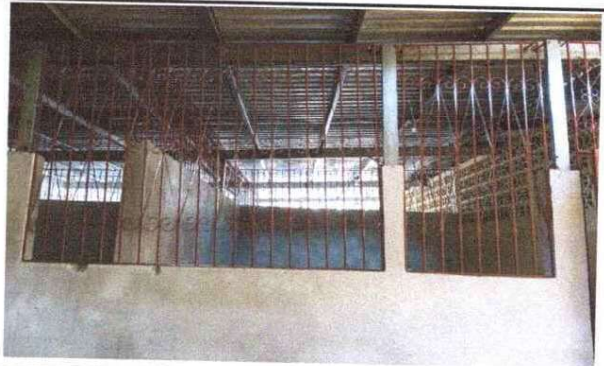
Foto 4: Se observa la finalización de instalación de balcones en aulas puras.
