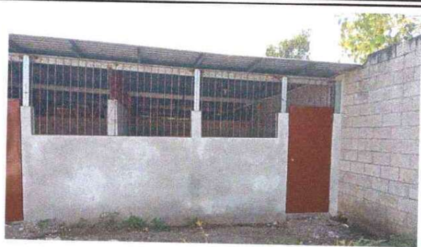
Foto 2: Se observa la finalización del repello de muros interiores e interiores.
