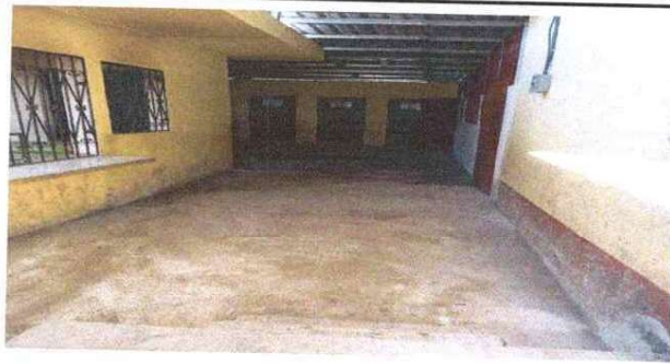
Foto 6: Se observa la finalización de torta de concreto en área exterior de cocina.
