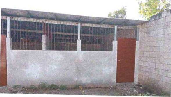
Foto 3: Se observa la finalización de instalación de puertas en aulas puras
