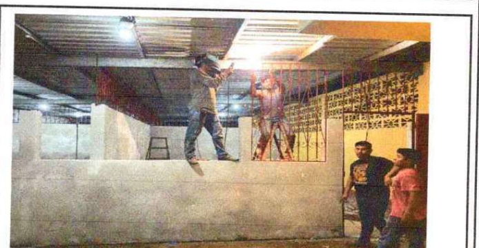
Foto 4: Se observa instalación de balcones en aulas puras
