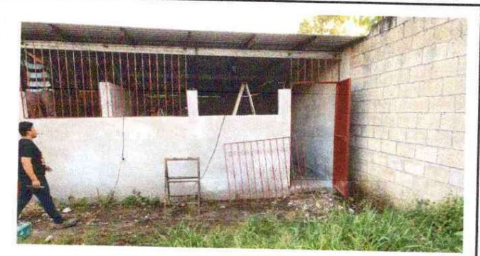
Foto 3: Se observa instalación de puertas en aulas puras
