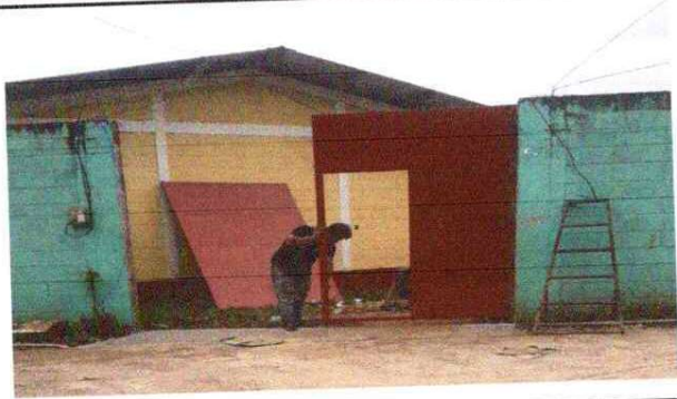
Foto 7: Se observa instalación de portón del centro educativo
