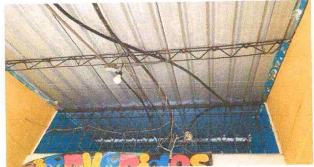
Foto 10: Se observa que estructura de soporte de metal necesita mantenimiento ( lijado, cepillado, y aplicación de pintura anticorrosiva)
