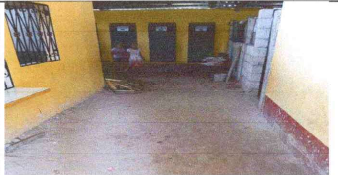
Foto 6: Se observa la falta de torta de concreto en área exterior de cocina.
