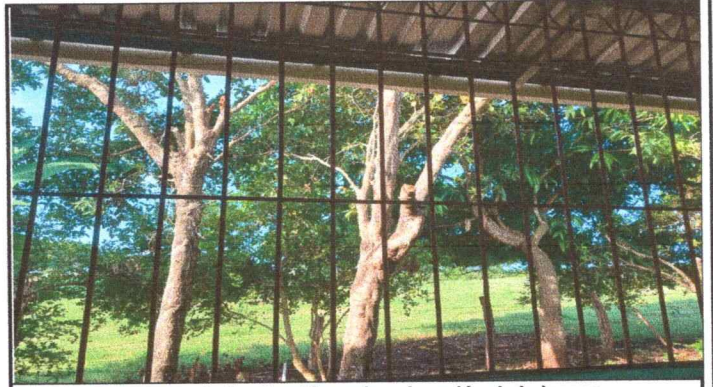
FOTO 2: Se observa la finalización en la colocación de balcones.
