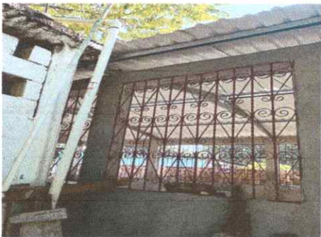
Foto 3: Se observa la finalización de la colocación de balcones
