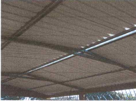
Foto 1: Se observa la finalización del techo
