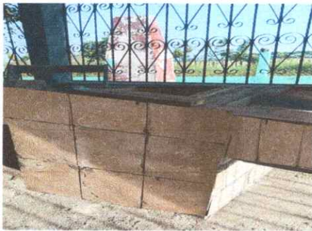
Foto 5: Se observa la finalización de la pila de concreto
