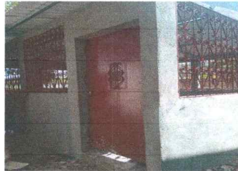
Foto 2: Se observa la finalización de la colocación de la puerta
