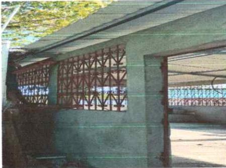
Foto 3: Se observa la colocación de los balcones de metal en la cocina
