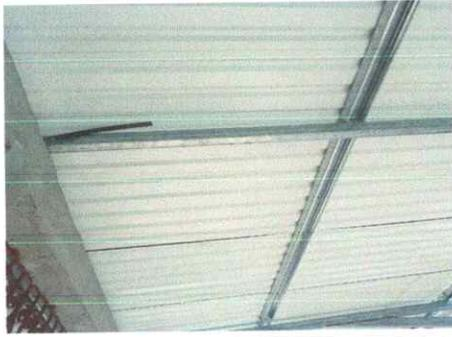
Foto 1: Se observa la instalación de estructura de metal y colocación de lamina troquelada
