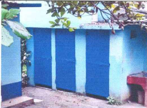
Foto 3: Se observa que las 3 puertas del servicio sanitario fueron sustituidas
