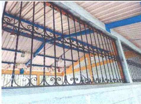
Foto 5: Se observa que los balcones de metal ha sido lijados y pintados de color negro.
