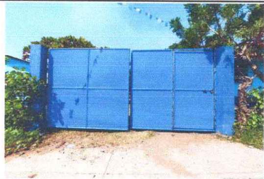
Foto 4: Se observa que se sustituyo el portón de láminas por un de metal color azul
