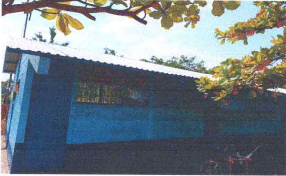
Foto 1: Se observa que las láminas ya han sido sustituidas.
