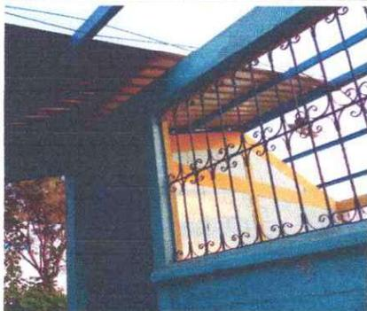
Foto 5: Se observa que los balcones de metal ya se encuentran lijados en espera de la pintura.
