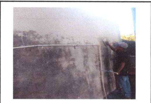
Foto 11: se observacion de aplicacion de savieta del muro perimetral que se ubica en el area de cocina
