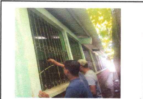
Foto 7: se observa que se esta dando mantenimiento a los balcones
