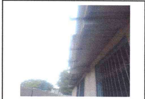
Foto 10: se observa que se esta colocando los canales.
