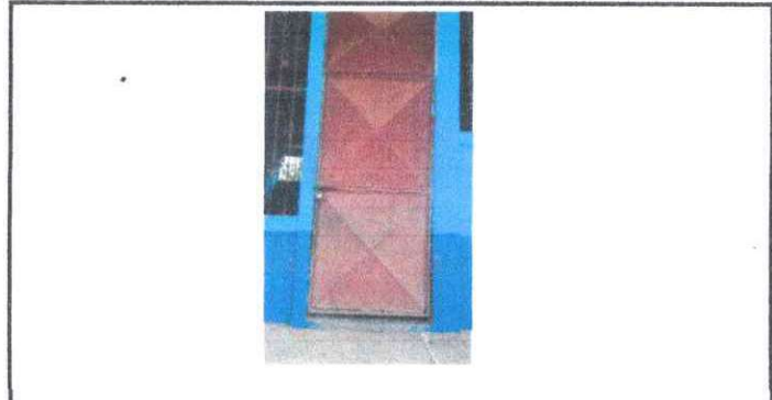
Foto 8: Suministro e instalación de chapa, para mas seguridad.
