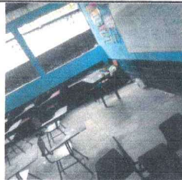
Foto 4: Suministro e instalación de piso cerámico.
