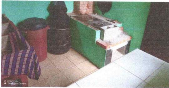
Foto 9: Se observa que la estufa de leña que estaba en mal estado ya fue finalizado el trabajo, en mejoramiento del piso y un banco de trabajo de concreto y azulejo.
