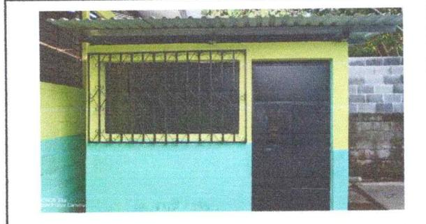
Foto 8: Se observa el trabajo finalizado en la lamina de zinc y su estructura como tambien la sustitución de ventanas y reparación de balcon.
