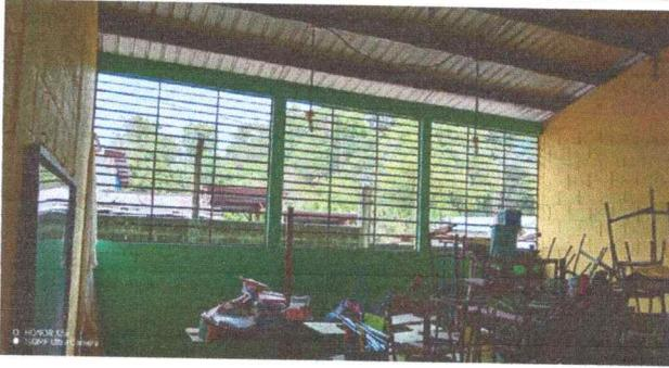
Foto 1: Se observa que las ventanas de metal y vidrio en mal estado ya se le brinda el mantenimiento necesario.
