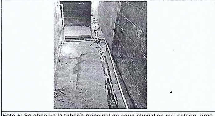
Foto 5: Se observa la tubería principal de agua pluvial en mal estado, urge sustituirla
