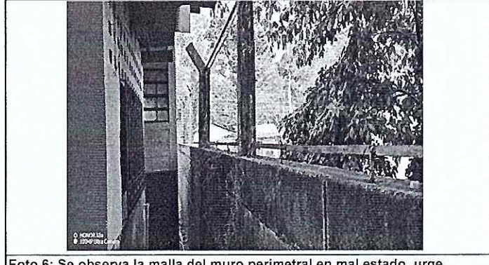
Foto 6: Se observa la malla del muro perimetral en mal estado, urge sustituirla por muro de block debido a la inseguridad en el lugar
