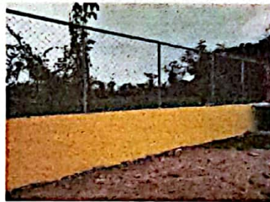
Foto 6: FOTOGRAFIA MEJORAMIENTO MURO PERIMETRAL CON MALLA
