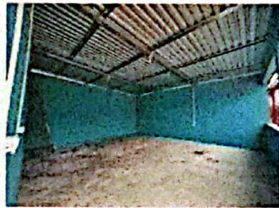
Foto 4: FOTOGRAFIA SUMINISTRO E INSTALACION DE ESTRUCTURA PORTANTE DE METAL, LAMINA TROQUELADA, MEJORAMIENTO PISO EN AULA, SISTEMA ELECTRICO ILUMINACION
