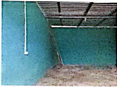
Foto 3: FOTOGRAFIA SUMINISTRO E INSTALACION DE ESTRUCTURA PORTANTE DE METAL, LAMINA TROQUELADA, MEJORAMIENTO PISO EN AULA
