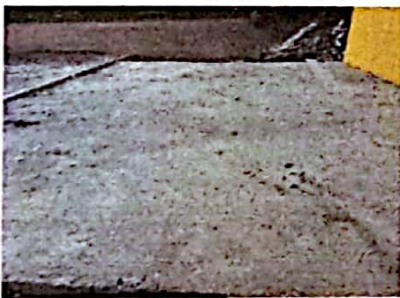
Foto 5: FOTOGRAFIA REPARACION DE PLANCHAS DE CONCRETO DE AULA (0.10M) DE ESPESOR
