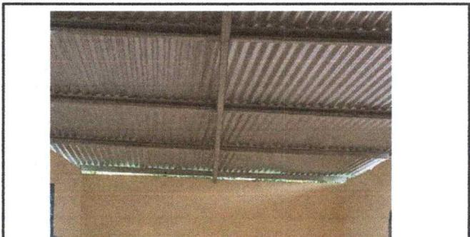
Foto 4: Se observa el cambio total de lámina metálica.
