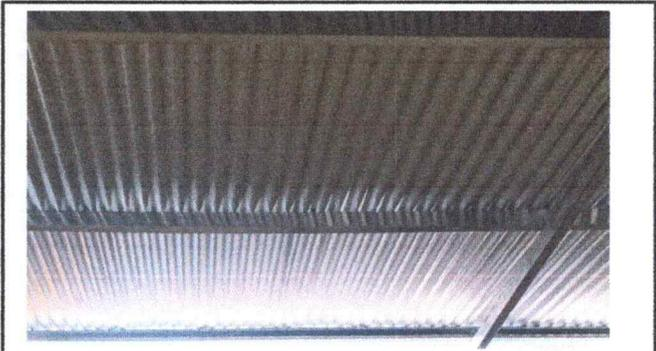
Foto 10: Se observa el cambio total de lámina metálica.
