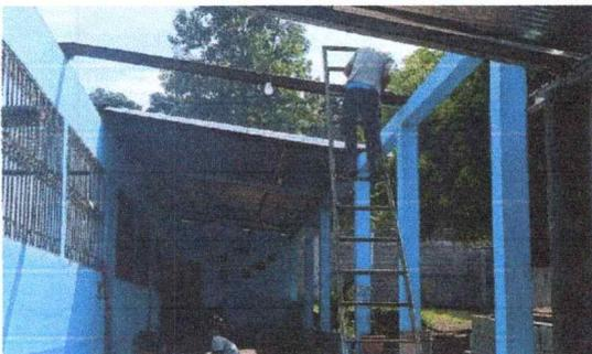
Foto 11: Se observa la extracción de la estructura de soporte metálica en mal estado.
