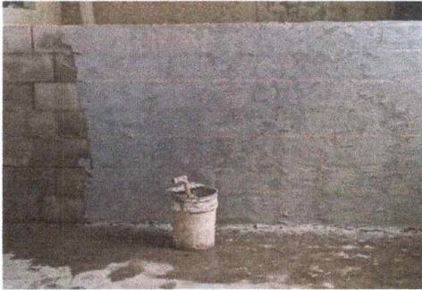
Foto 7: Se observa las paredes en repello.
