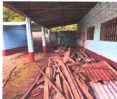
Foto 6: Se observa la falta de torta de concreto en área exterior del aula del modulo II
