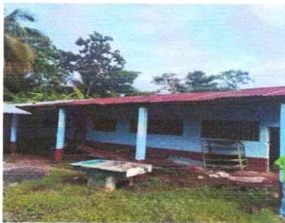
Foto 1: Se observa que el techo de modulo II esta en mal estado es necesario su sustitucion.
