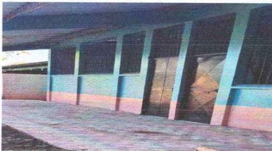
Foto 5: Se observa que ya se finalizó el mantenimiento de puertas (incluye lijado, cambio de tubo, cepillado, sujeciones, aplicación de pintura).
