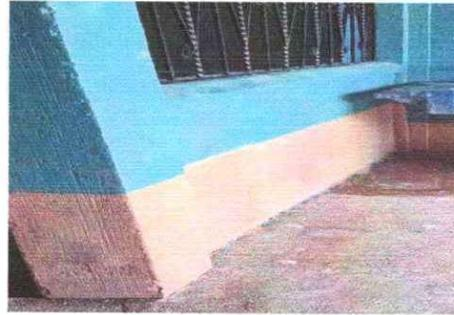
Foto 8: Se observa que ya se culminó el resane y aplicación pintura latex acrílica en muros exteriores e interiores (incluye mejora en deformaciones y agujeros).
