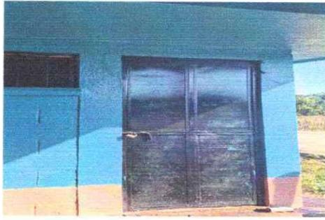
Foto 7: Se observa que ya se terminó el mantenimiento a estructura (lijado, cambio de tubo, cepillado, sujeciones, aplicación de pintura) a puertas servicios sanitarios.
