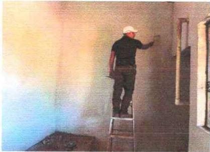
Foto 3: Se observa que se está realizando el sellado en grietas y fisuras en muros.
