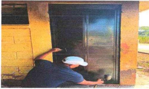
Foto 7: Se observa que se le está dando mantenimiento a estructura (lijado, cambio de tubo, cepillado, sujeciones, aplicación de pintura) a puertas servicios sanitarios.
