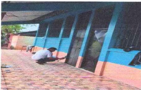
Foto 5: Se observa que se le está dando mantenimiento de puertas (incluye lijado, cambio de tubo, cepillado, sujeciones, aplicación de pintura).
