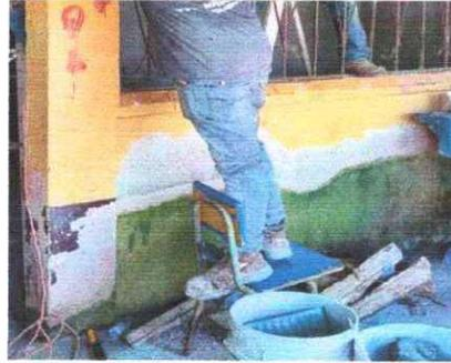
Foto 8: Se observa que se está realizando el resane y aplicación pintura latex acrílica en muros exteriores e interiores (incluye mejora en deformaciones y agujeros).
