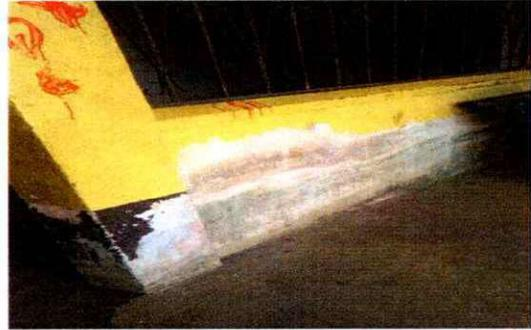
Foto 8: Resane y aplicación pintura latex acrílica en muros exteriores e interiores (incluye mejora en deformaciones y agujeros).
