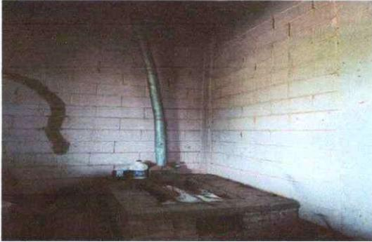
Foto 1: Se observa en mal estado la estufa rural (completa) incluye chimenea y plancha de metal.
