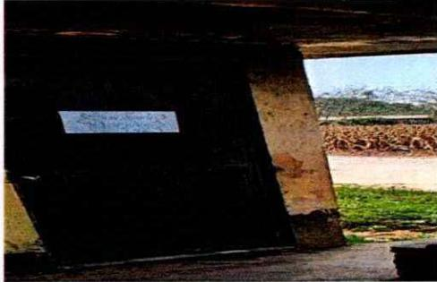
Foto 7: Se observa que se necesita mantenimiento a estructura (lijado, cambio de tubo, cepillado, sujeciones, aplicación de pintura) a puertas servicios sanitarios.
