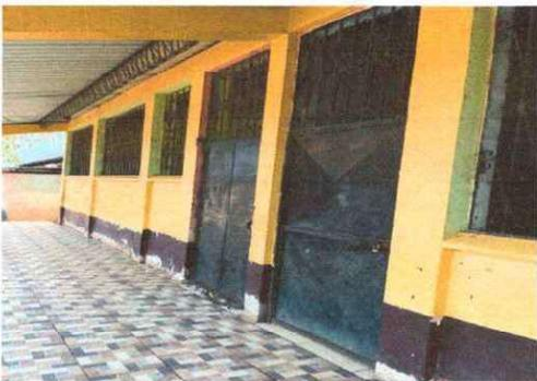
Foto 5: Se observa que se necesita mantenimiento de puertas (incluye lijado, cambio de tubo, cepillado, sujeciones, aplicación de pintura).
