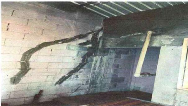
Foto 3: Se observa que la pared necesita mantenimiento, sellado en grietas y fisuras.
