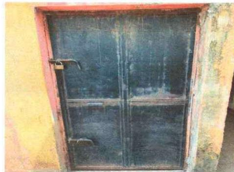
Foto 4: Se observa que la puerta se encuentra en mal estado, se necesita sustitución.
