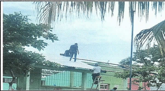
Foto1: Se inicia la sustitucion de laminas y estructuras de soporte.
