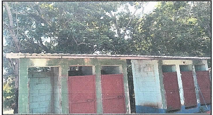
Foto 2: Se inicia la sustitucion de lamina, estructura y letrinas como tambien mantenimiento de puertas y pintura.
