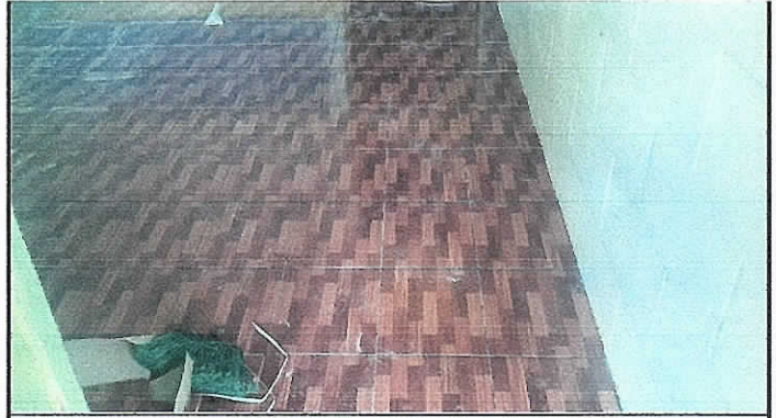
Foto 4: inicio de instalación de piso seramico en la direccion del establecimiento.
