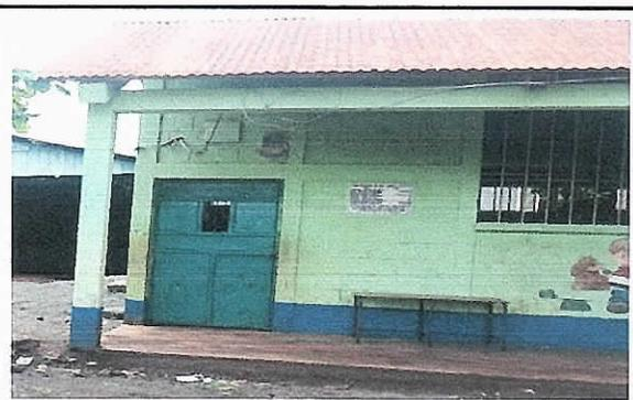
Foto 6: Se observa que las puertas de las dos aulas necesitan mantenimiento como el cambio de las chapas y necesita aplicación de pintura.
