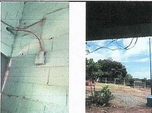
Foto 5: Se observan el cableado eléctrico debe ser cambiado se encuentra en mal estado y peligroso para los estudiantes.
