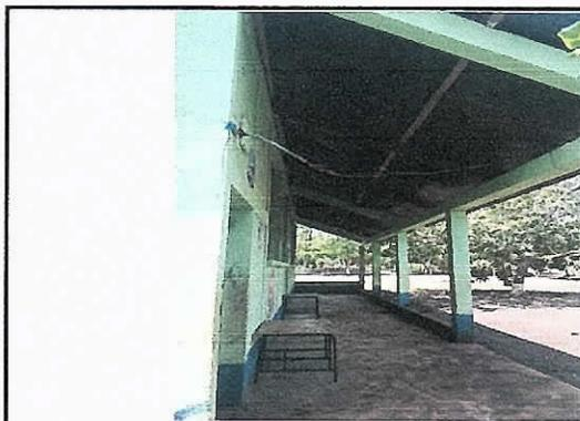
Foto 4: Se observan que en las laminas y las reglas de madera ya se encuentran en mal estado.
