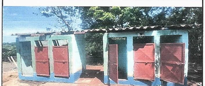
Foto 2: Se observa que hace falta una puerta para un sanitario, como también mantenimiento a las 5 puertas que se encuentran deterioradas.
