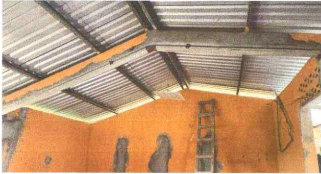
Foto 7: Se observa que se instaló el soporte de metal para el módulo I.
