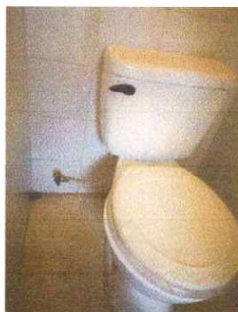
Foto 3: Se hizo mantenimiento en inodoros del servicio sanitario.
