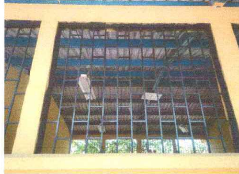
Foto 8: Se observa que se hizo el mantenimiento necesario de balcones en módulo III.
