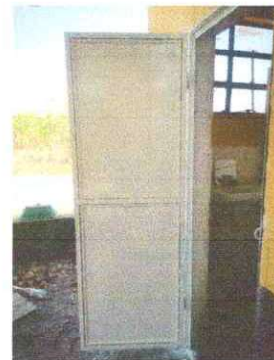
Foto 2: Se observa que se sustituyó la puerta en el módulo de servicios sanitarios.
