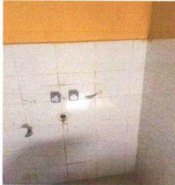
Foto 1: Se observa que en módulo de servicios sanitarios se removieron los lavamanos deteriorados para instalar los nuevos.
