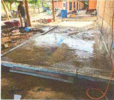
Foto 13: Se observa que se está hechando nueva torta de concreto en respectivos pasillos.
