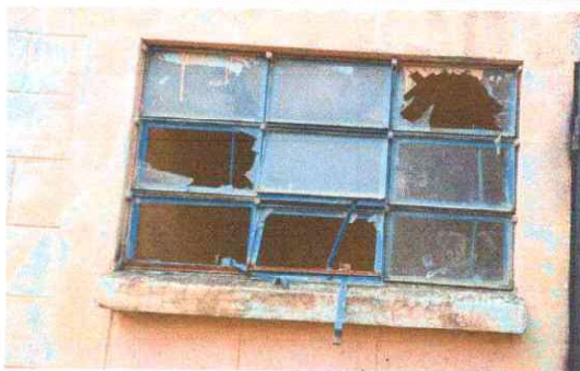
Foto 5: Se observa que es necesario sustituir ventana por deterioro.
