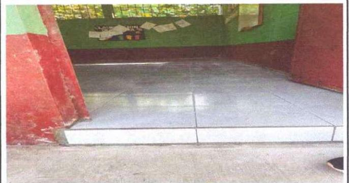
Foto 2: Se observa que ya se realizó la sustitución de piso cerámico en el módulo I y II.
