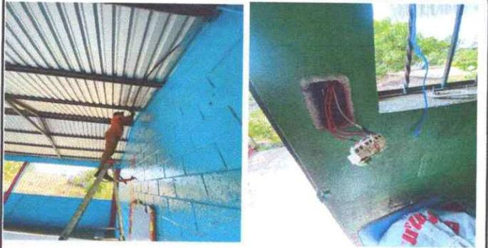
Foto 1: Se observa que se esta realizado la sustitución del sistema eléctrico en el módulo I y II.
