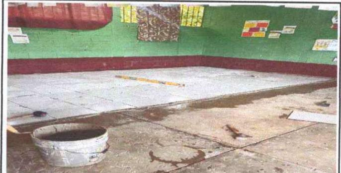
Foto 2: Se observa que estan realizando la sustitución de piso cerámico en el módulo I y II.
