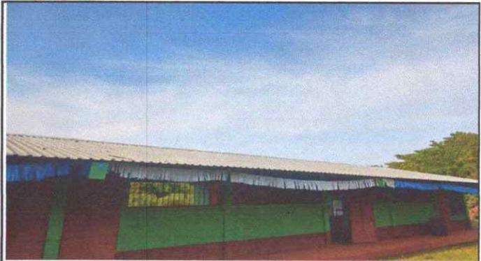
Foto 4: Se observa que es necesario instalar canales pluviales de calidad en el Módulo I.
