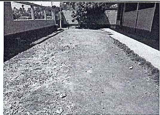
Foto 8: Se observa el área de patio a pavimentar
