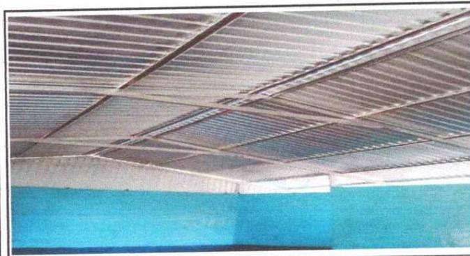
Foto 9: se observa la estructura de madera ya fue sustuida por metal
