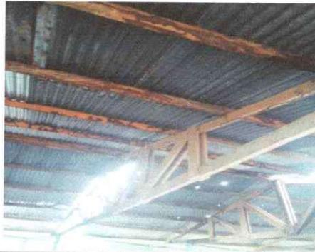
Foto 3: Se observa que la estructura de soporte de madera es necesaria sustituirla por metal
