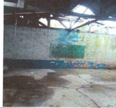
Foto 2: Se observa que el techo del salón de usos múltiples esta en mal estado es necesario su sustitucion.
