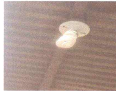
Foto 4: Se observa la sustitución del sistema eléctrico.
