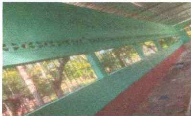
Foto 5: Se observa sustitución de pintura,
