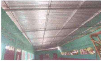
Foto 1: Se observa sustitución de techo y estructura portante.
