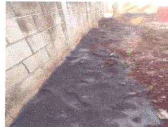
Foto 6: Se observa tubería de drenaje instalado.
