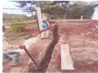
Foto 6: Se observa el proceso de cambio de tubería de drenaje
